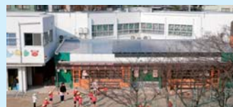
かがやきおひさま発電所
