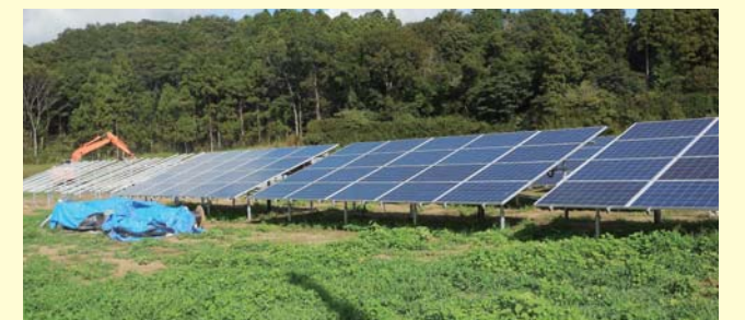
鹿島灘2号太陽光分譲ファンドにより建設中の発電所
